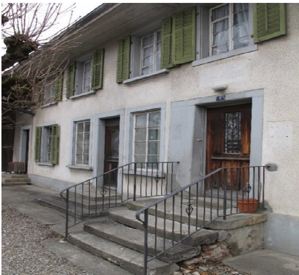
Mellingerstrasse 8, Fischbach-Göslikon: Aufnahme: 13. Februar 2017
