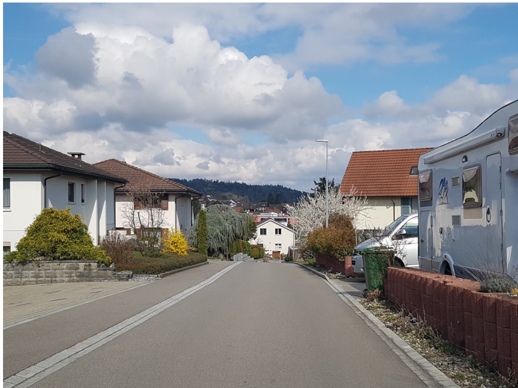
Abbildung 9: einseitiges, schmales, überfahrbares Trottoir, Hinterdorfstrasse
