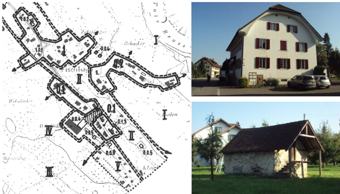
Abbildung 10: Ausschnitt Fischbach; Fotos „alte Post“, Steinspeicher
